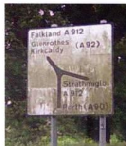
Before - 洗浄後に施工 -
